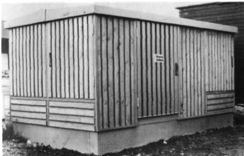
Kiosk ferdig; frå fabrikk. 1987,
