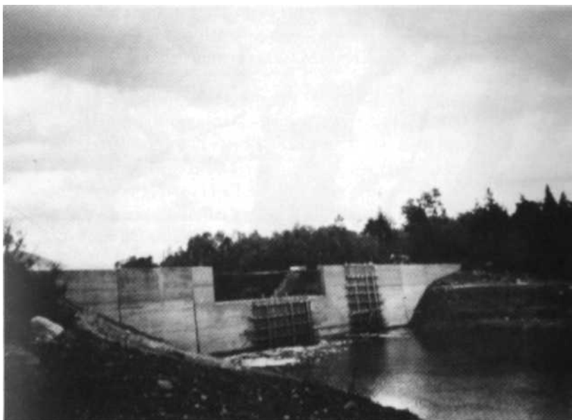
Reparasjonen nesten ferdig. Forskalinga på siste støypen måtte sjå over vinteren.
