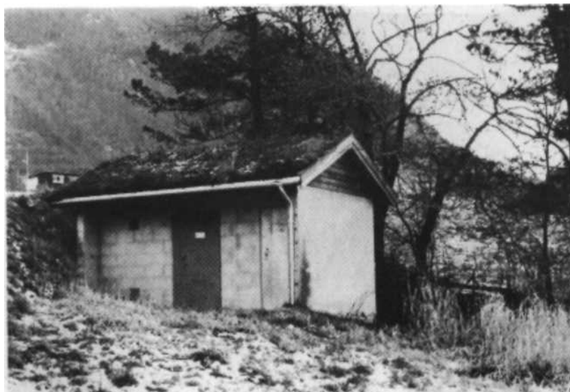
Kiosk for kraft- og Televerket. Bygd på plassen i 1977,
