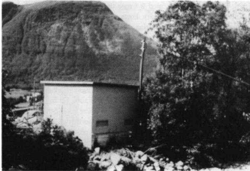
Transformatorkiosk ved Nor-laks, ein av dei 20 kioskane som er bygde siste åra.
