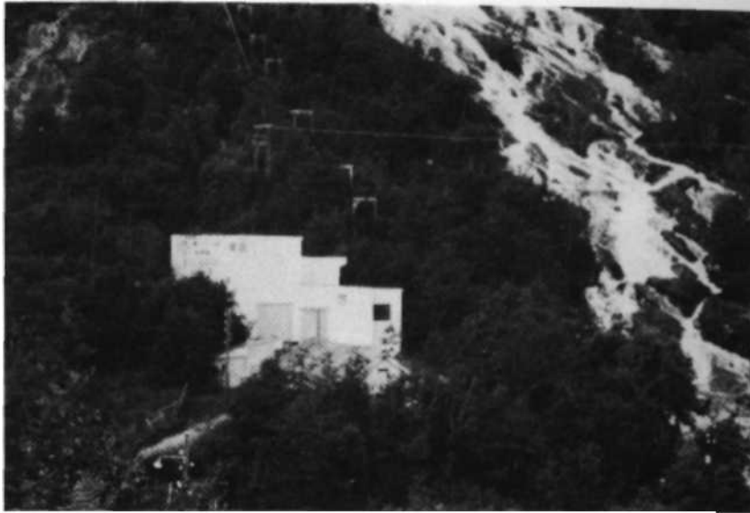
Riksheim kraftstasjon etter utvidinga i 1958
