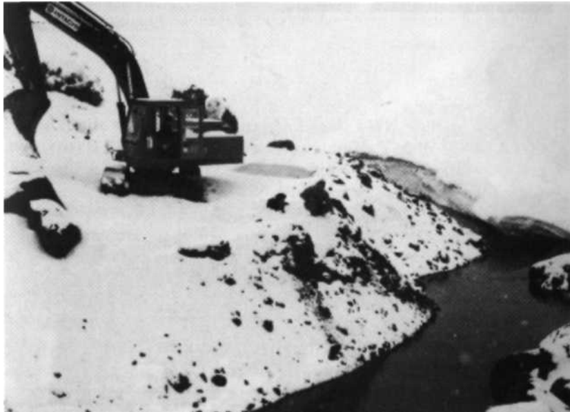
Opprensninga ferdig. Biletet vise kanalen inne i vatnet
