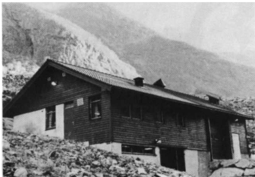
Ramstaddal. Vassverk og kraftstasjon.
